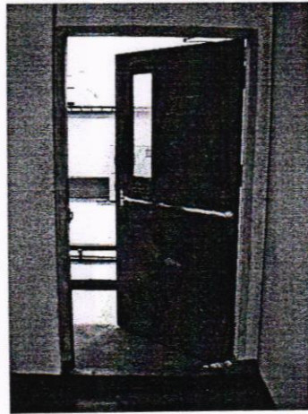
รูป 2.1 ประตูหนีไฟของบันไดหนีไฟที่ 1
