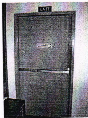
รูป 2.2 ประตูหนีไฟของบันไดหนีไฟที่ 2
