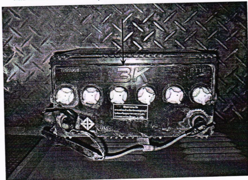
มีแบตเตอรี่สำหรับแสงสว่างฉุกเฉิน-กระดิ่งแบบเติมน้ำกลั่น เครื่องที่ 3.
